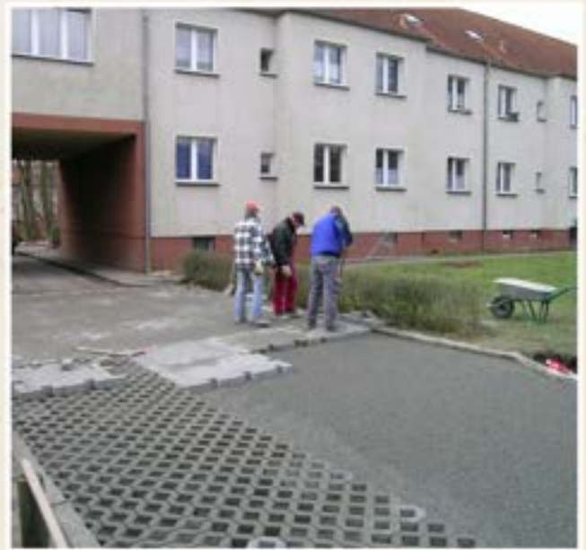
Bauarbeiten Mosel- & Friedensstraße
