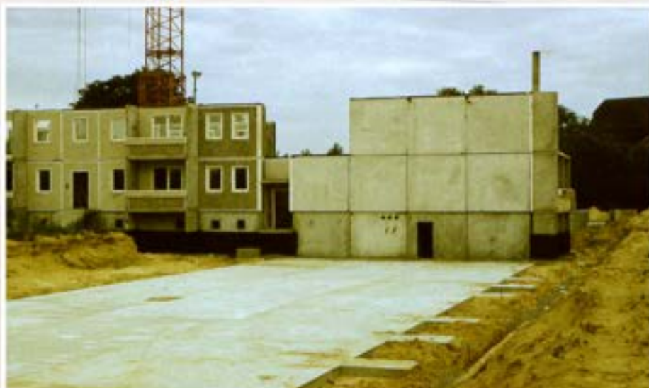
Wohnkomplex am Ruhlsdorfer Platz
