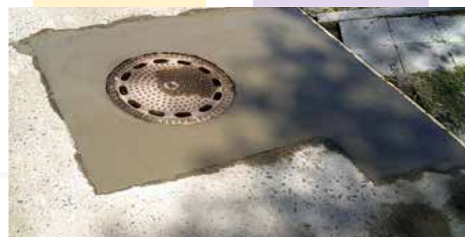
Elbestraße 15 a Ausbesserung Fahrbahn
