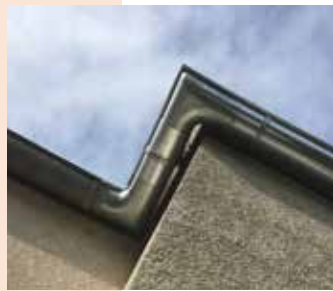
August Bebel Straße 10 Dach
