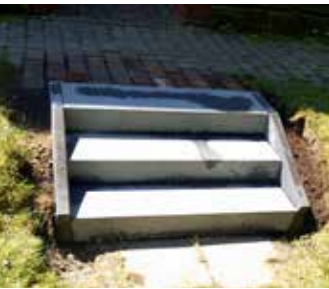
Paul - Singer - Straße 4 Außentreppe
