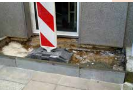
A. - Wiebach - Straße 1 a Hauseingangspodest
