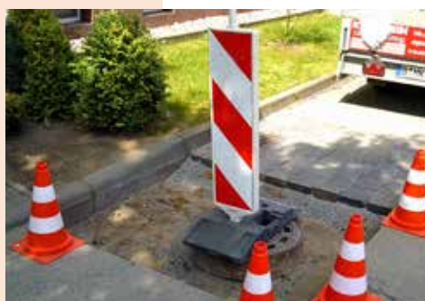
Elbestraße 11 a - d Ausbesserung Fahrbahn
