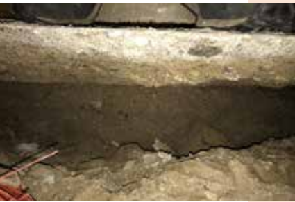
Friedensstraße 11 bis 17 Abwasser- und Gebäudeanschlussleitungen
