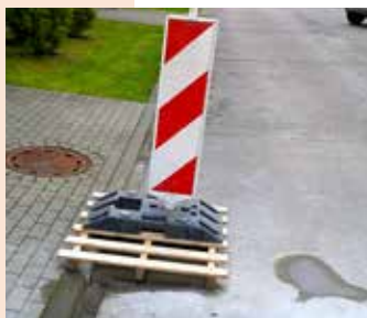
Bodestraße 6 a Ausbesserung Fahrbahn
