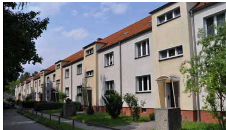
August - Bebel - Straße 4 bis 16 Dächer
